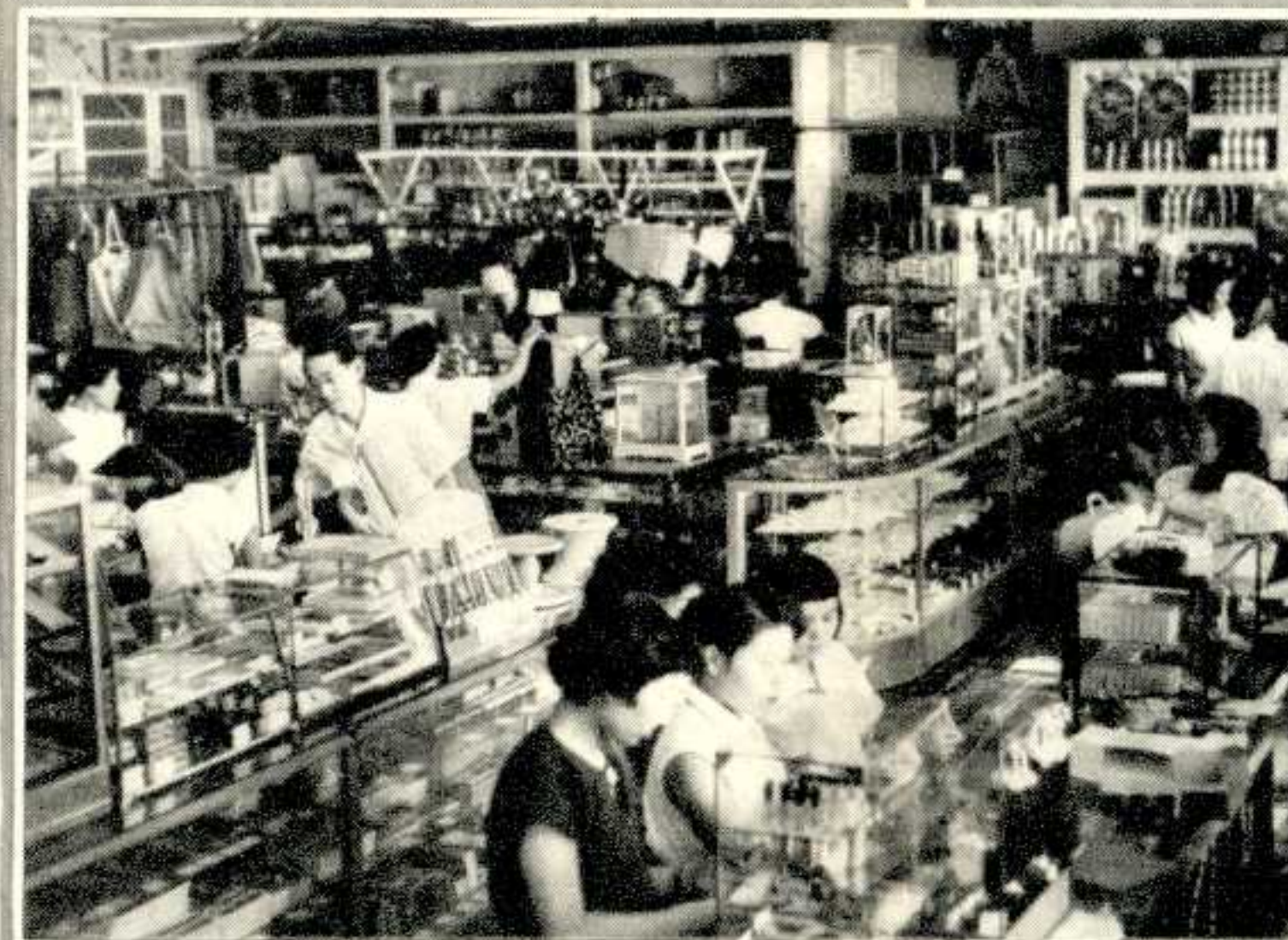
婦人寮 簡易洗濯所 地域生活協同組合 労働金庫
