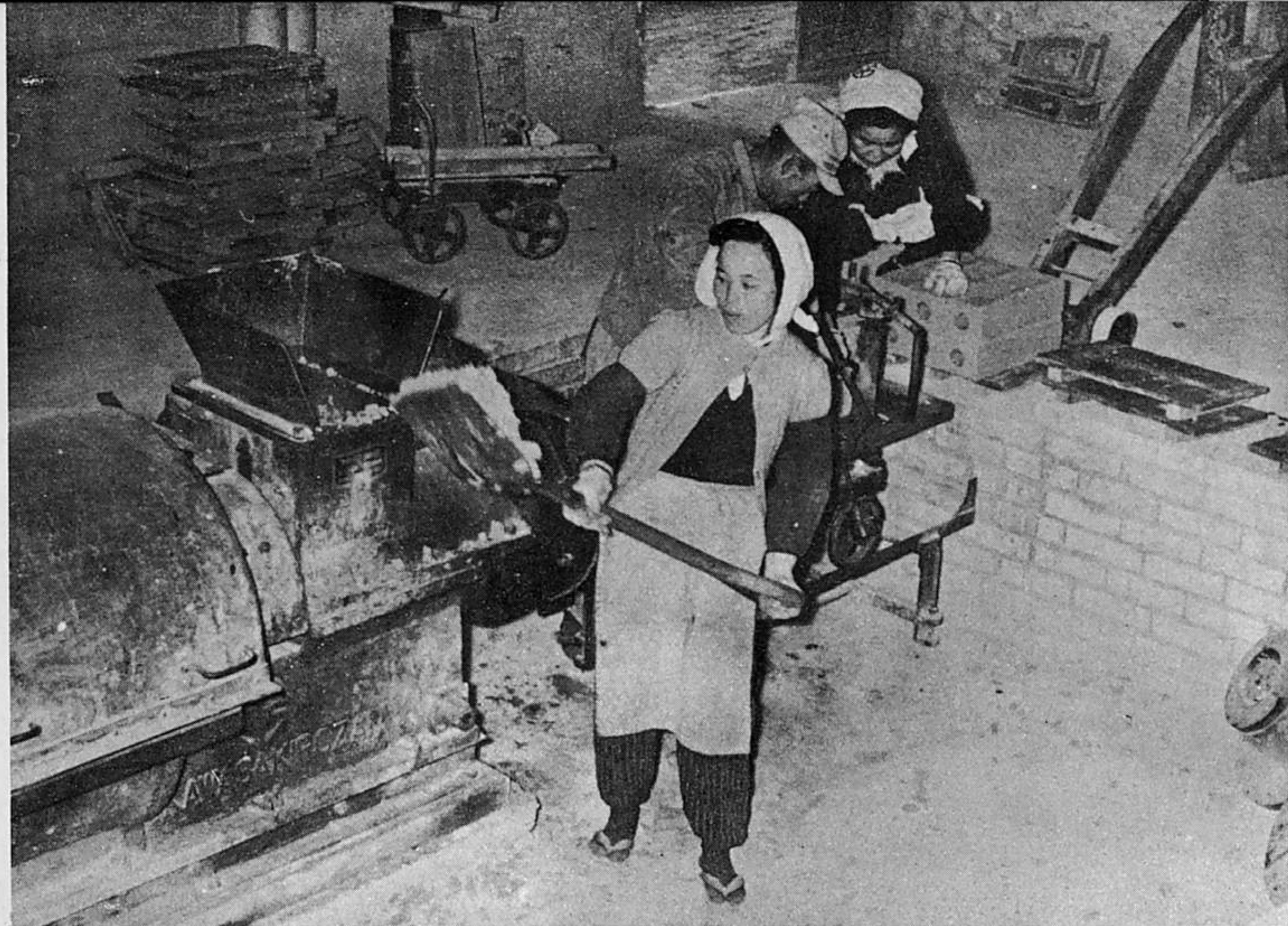
煉瓦工場（岡山）
